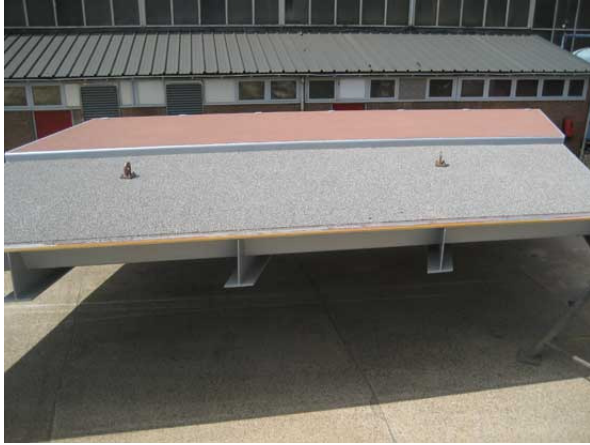
(verkeersbrug gereed, voorzien van polyurethan coating en slijtlaag)
