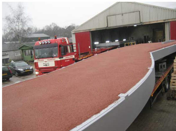
(voetgangersbrug voorzien van aflak en slijtlaag)
