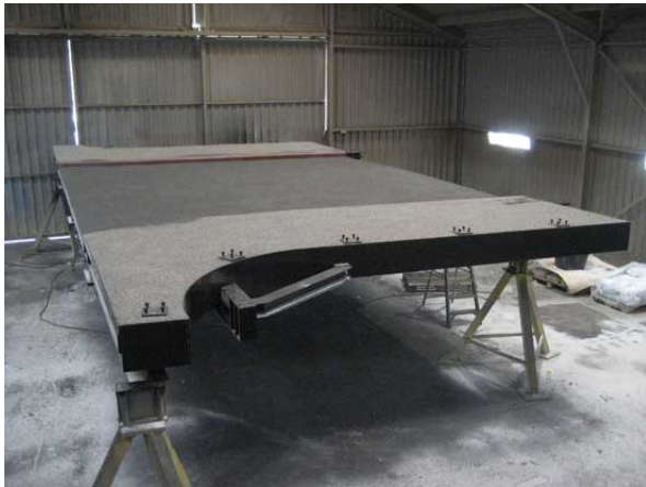
(overzicht aangebrachte epoxy slijtlaag op brugdelen Muraltplein)
