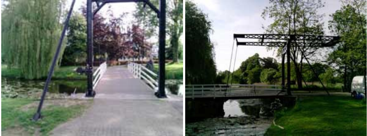
(overzicht Washuisbrug tijdens bijwerken van montagebeschadigingen)
