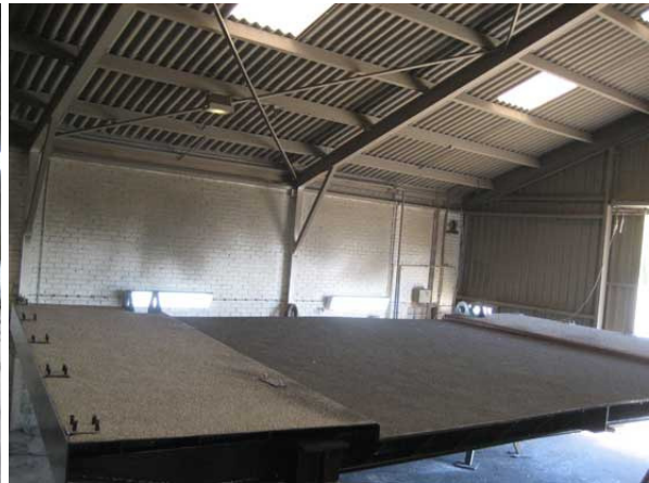
(overzicht aangebrachte epoxy slijtlaag op brugdelen Muraltplein)
