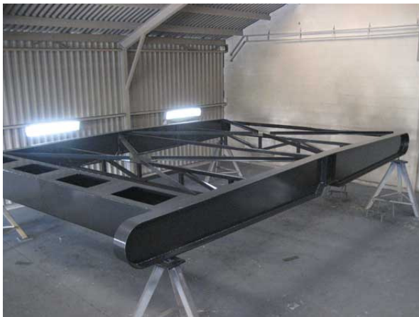
(overzicht balansdeel coating gereed)
