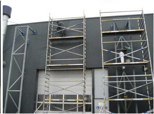
(hoge druk nareinigen en verwijderen van zinkzouten van de kolommen als voorbehandeling voor het conserveren)
