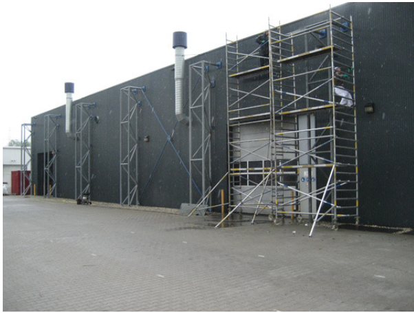
(hoge druk nareinigen en verwijderen van zinkzouten van de kolommen als voorbehandeling voor het conserveren)
