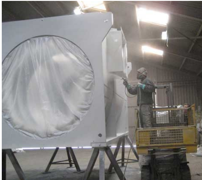
(aanbrengen van polyurethan eindlaag)
