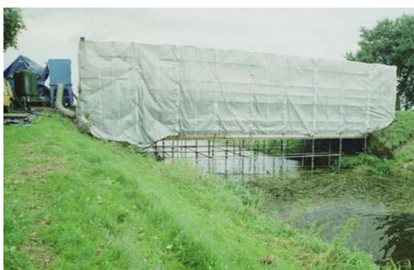
(brug volledig ingepakt m.b.v. steigers en zeilen)
