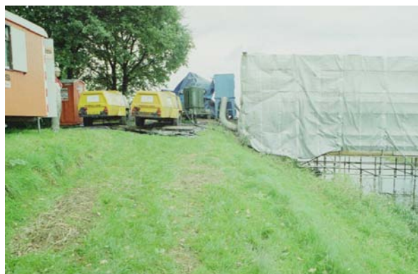
(brug volledig ingepakt m.b.v. steigers en zeilen)
