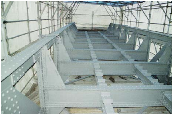
(overzicht na aanbrengen van coating)
